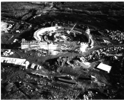
Construction de PB1
