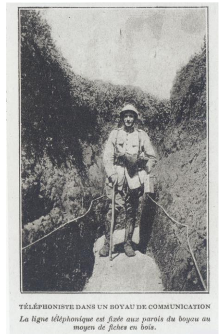
TÉLÉPHONISTE DANS UN BOYAU DE COMMUNICATION La ligne téléphonique est fixée aux parois du boyau au moyen de fiches en bois. Source : Orange / DGCI
