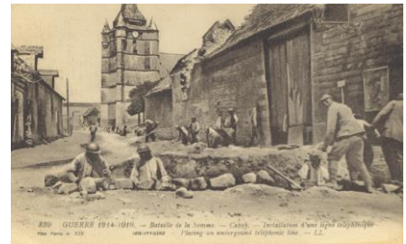
Installation d'une ligne téléphonique enterrée 1916 Source : Orange / DGCI
